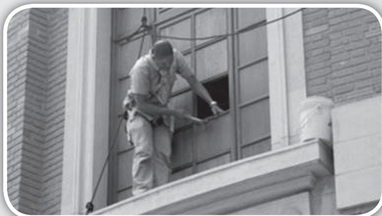
Montaje de tableros en ventanas para optimizar la acústica dentro del auditorio, posteriormente se aplicarán varias capas de pintura para mejorar el acabado en las ventanas de madera instaladas.
