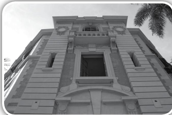
Detalle de la fachada por el costado del ochave, una vez lavada e hidrofugada
