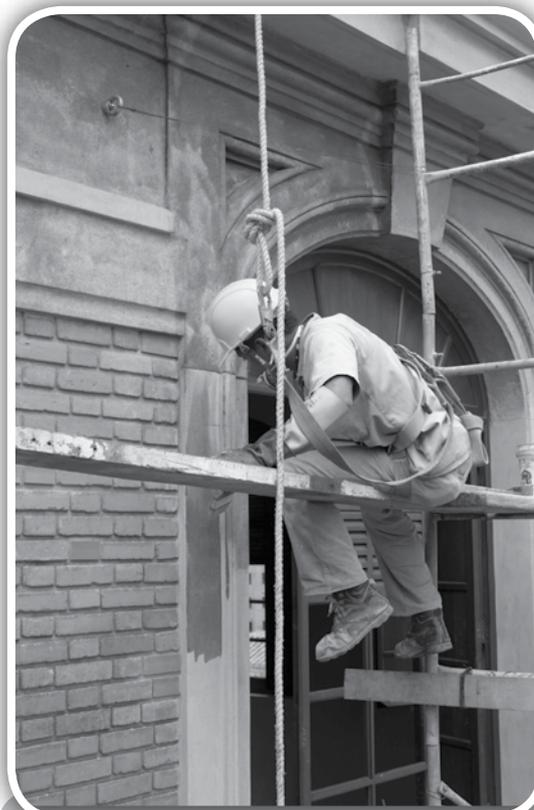
Aplicación de material de hidrófugo por brochado
