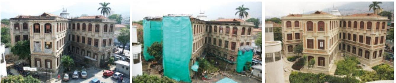
Fotografías del antes, durante y después de las obras. En 2006, la Facultad incluyó en su Plan de Acción, la restauración del antiguo edificio de Bioquímica diseñado por Agustín Goovaerts y construido entre 1926-1929. La estructura estaba casi en ruínas, las ventanas eran cubiertas con plásticos, la humedad invadía la mayoría de espacios y las condiciones de bienestar para la comunidad universitaria eran mínimas.
