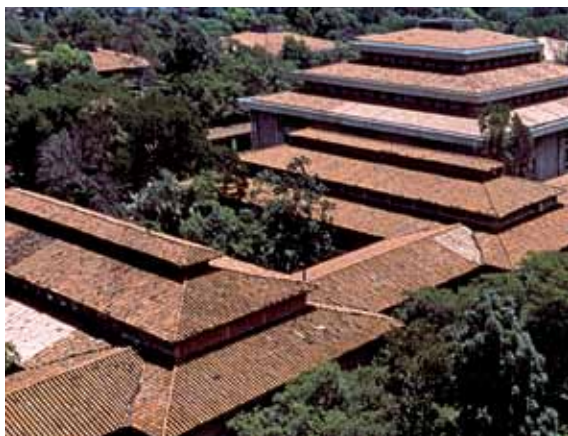
Reparación y cambio de techos (inicio 2006)
