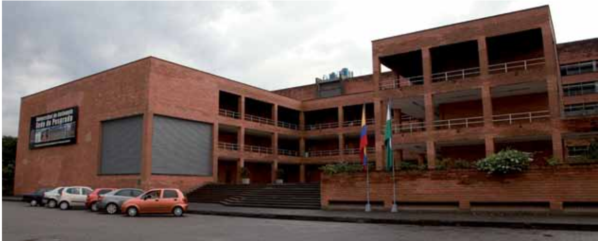
Edificio de Posgrados, sede Guayabal
