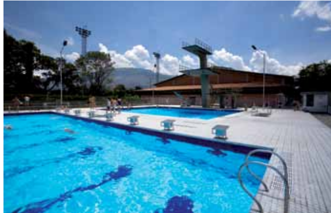
Impermeabilización y cambio de baldosín de las piscinas (2008)
