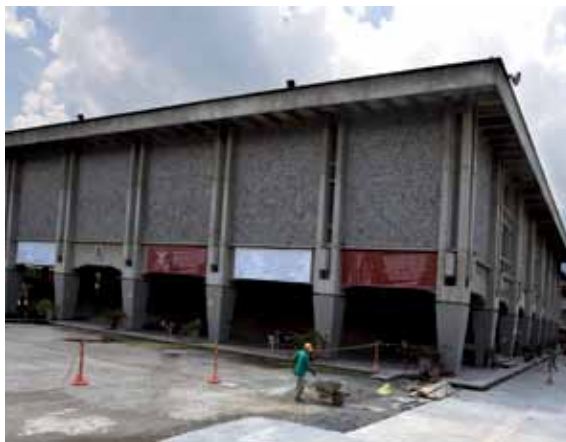
Cambio y reparación de placas de la Plazoleta Central (2007)
