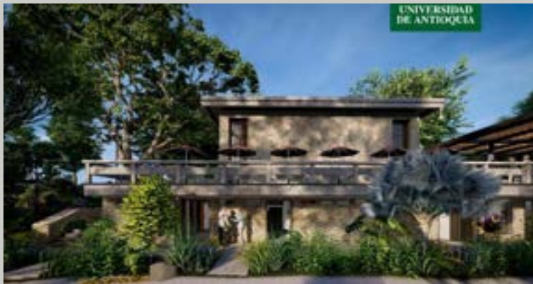
Adecuación de infraestructura Bloque 17. Sala de artes performativas Teresita Gómez
